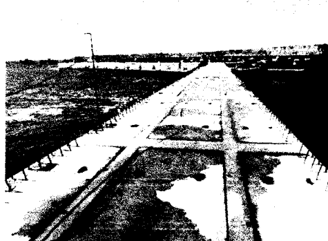
Fotografía N°04: vista de losas.
