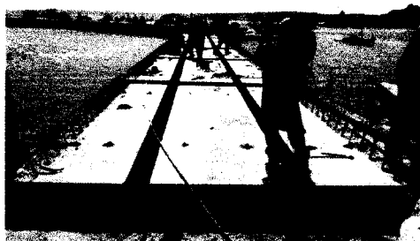
Fotografía N°06: colocación de losas prefabricadas.
