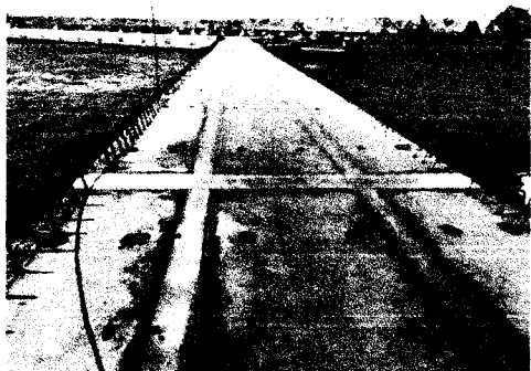
Fotografía N°03: curado de juntas de losas
